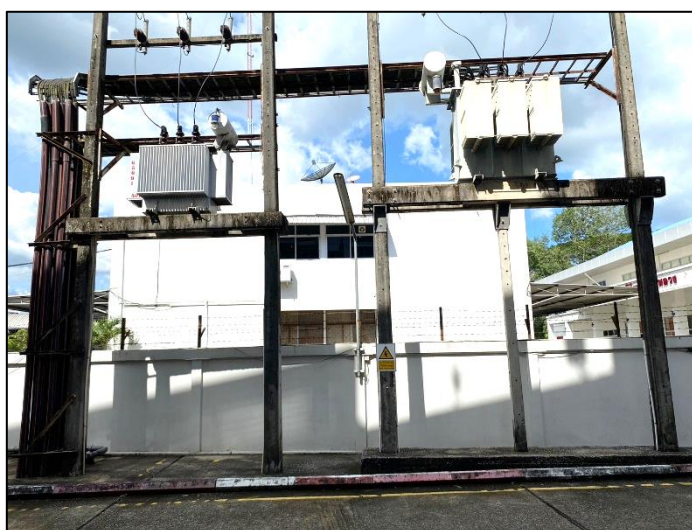
เสาไฟฟ้าและหม้อแปลงไฟฟ้า พร้อมติดป้ายเตือน “อันตรายไฟฟ้าแรงสูง”
